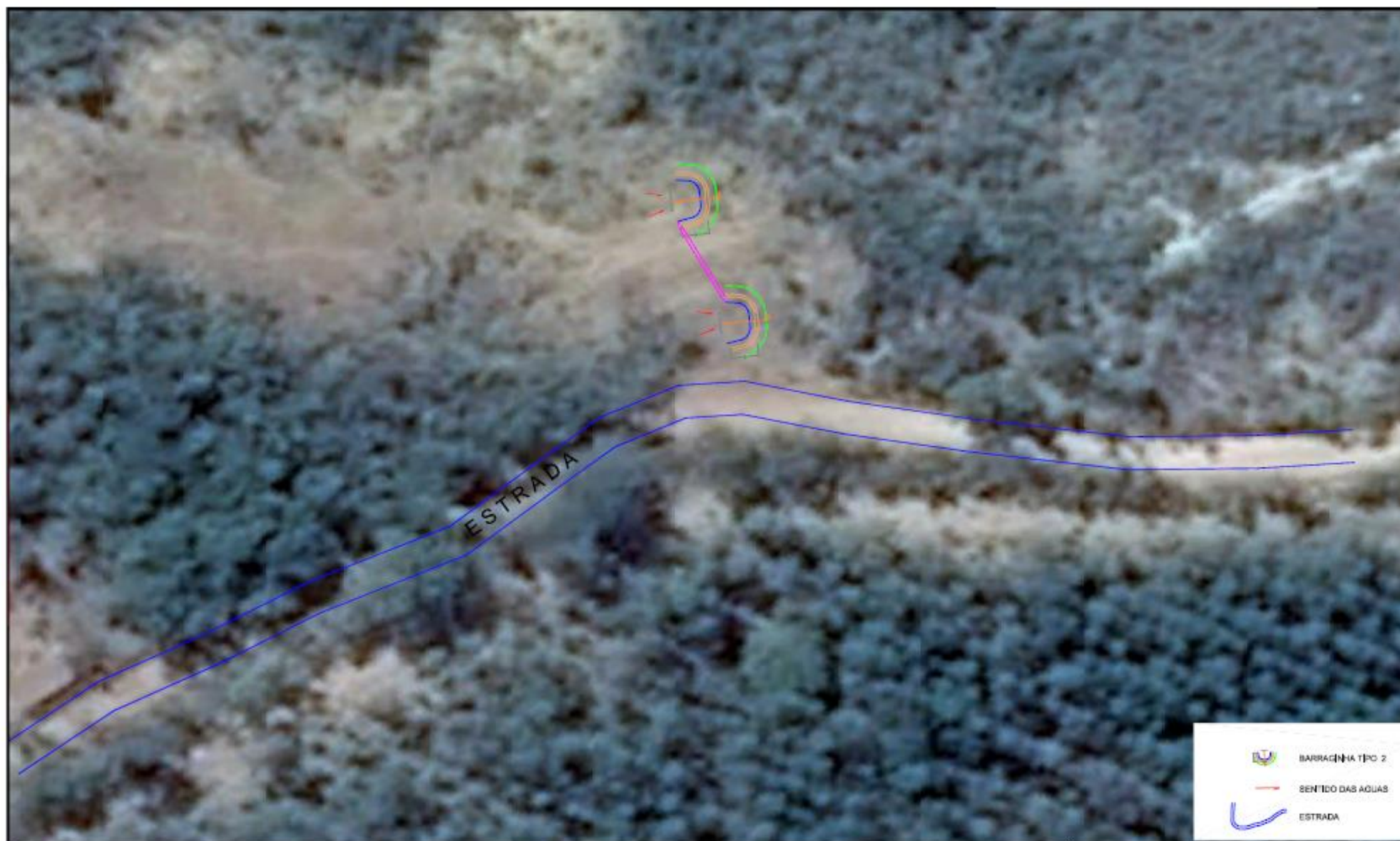
Figura 31: Intervenções para disciplinamento das águas de enxurrada causadoras da erosão
